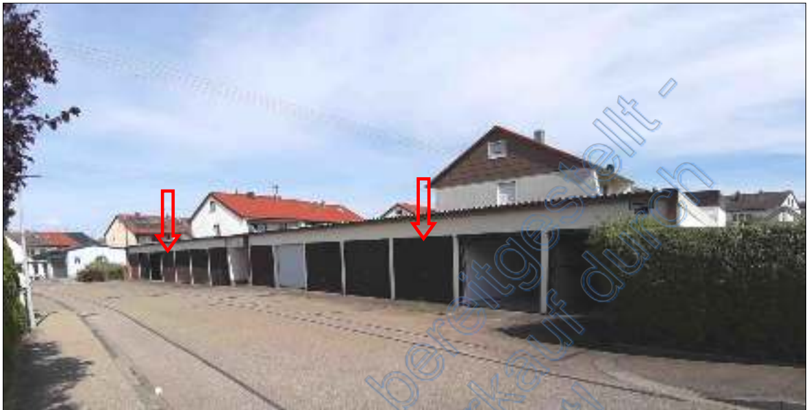
Garagen am Brezgerweg, Bewertungsobjekt Garagen mit Pfeil markiert
