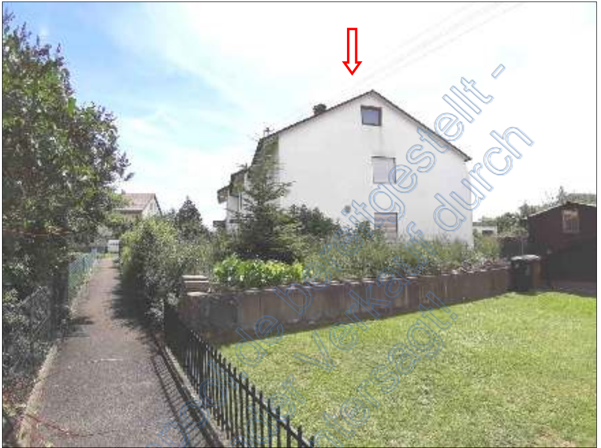
Ansicht Nord, Zugang vom Weggrundstück Brezgerweg
