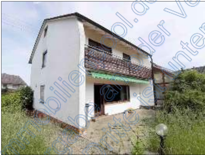
Ansicht West, Terrasse
