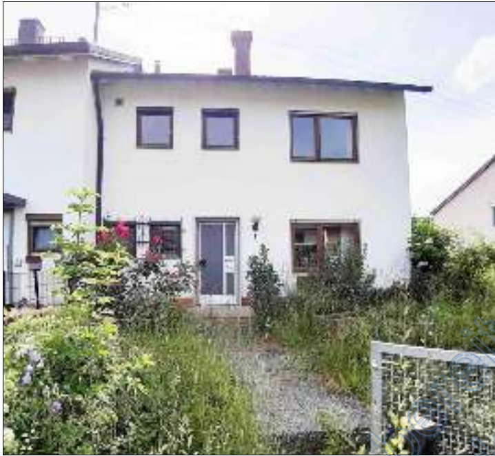
Ansicht Ost, Eingang
