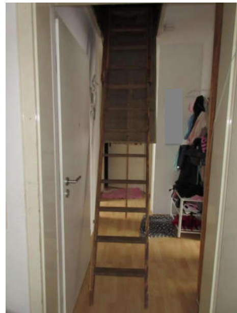
Einschubtreppe zum Spitzboden
