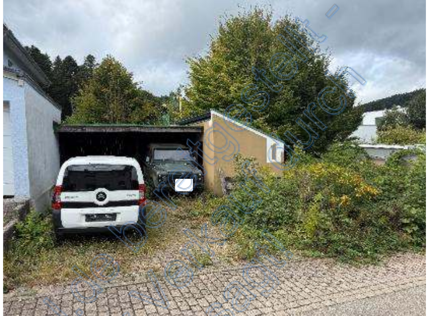
Foto 1 des SV: Ansicht von Osten, Straßenansicht (Neufeldweg), Grundstückszugang
