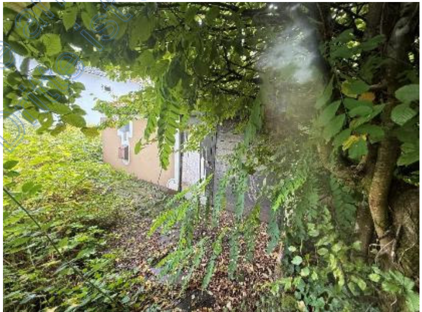
Foto 4 des SV: Ansicht von Norden, Eingang zum Geräte-/Tankraum
