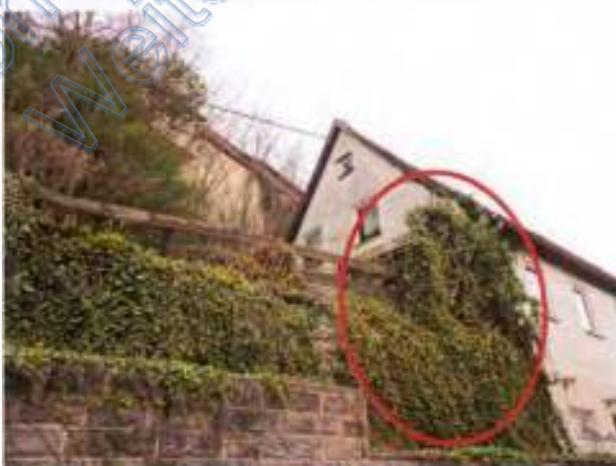
Außenansicht Gebäude und Efeubewuchs
