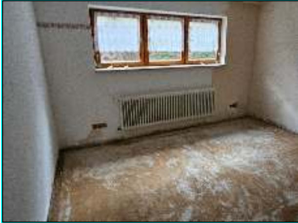
Ausbauzustand Raum im Untergeschoss, Althaus (konzeptionell für Wellness/Massage/Kosmetik Anwendungen nutzbar)
