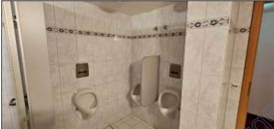
Allgemeine Toilette EG Altbau
