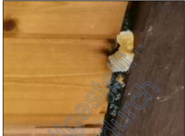
Möglicher Pilzbefall
