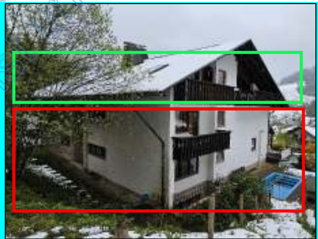
Ansicht Althaus Nordwestseite
