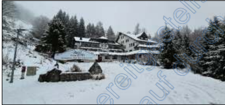
Straßenansicht (Blick nach Norden)
