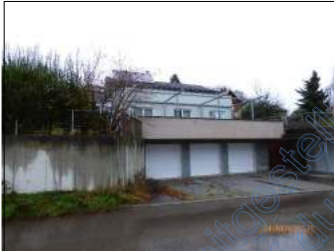
Ansicht: Südseite, Terrassenbrüstungen (Bild 4)
