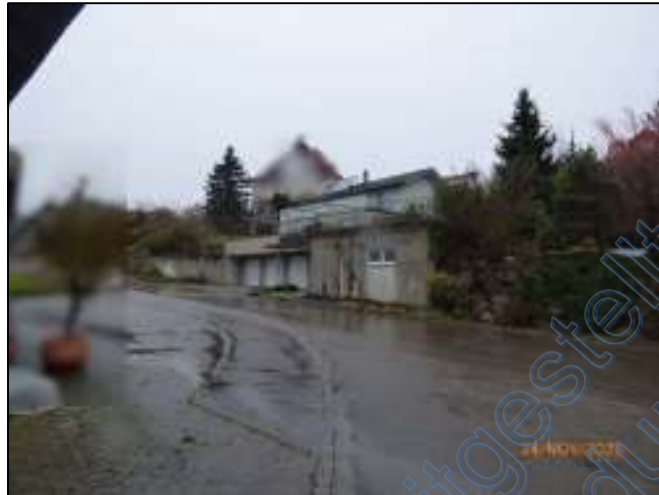
Ansicht: Südosten - Dorfstraße (Bild 1)
