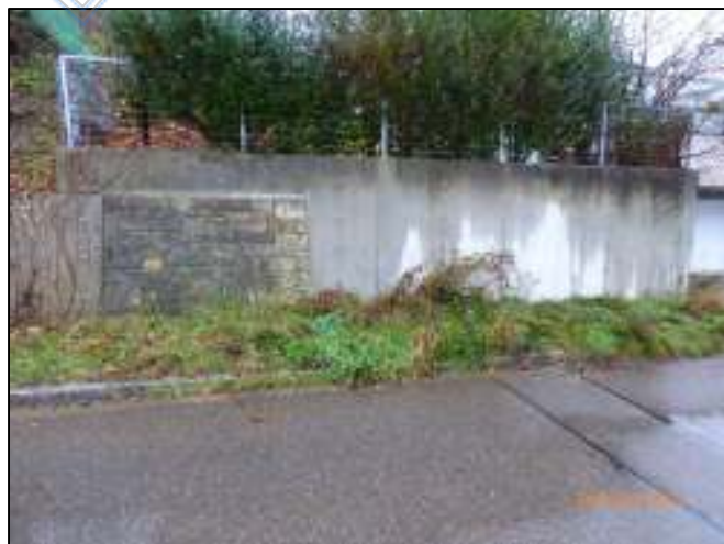
Ansicht: Stützmauer (Bild 9)
