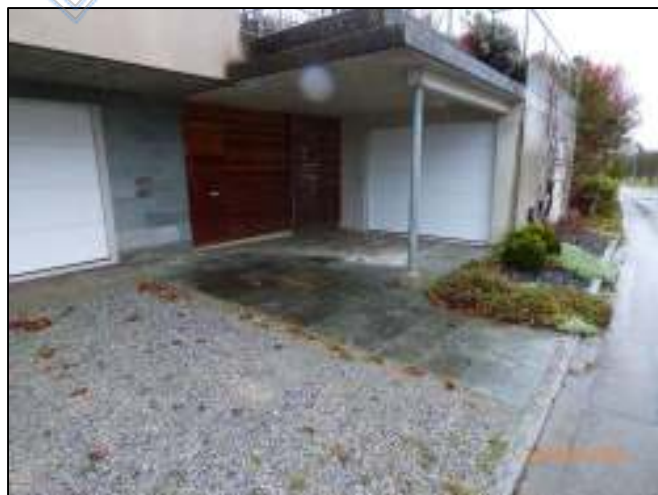
Ansicht: Grundstückszugang (Bild 6)
