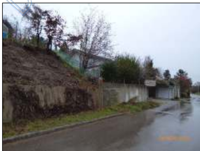
Ansicht: Westseite (Bild 3)
