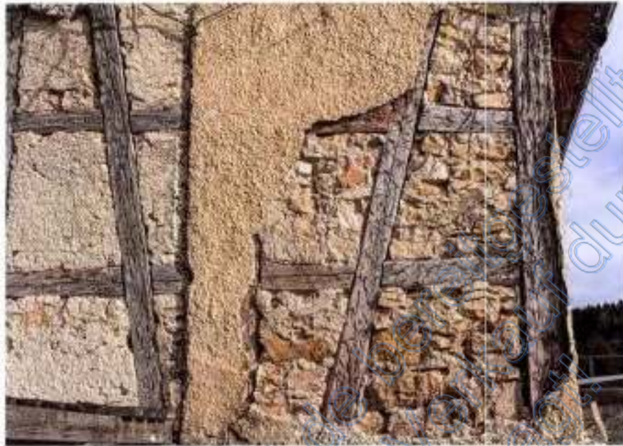
Bild 7: fehlende Fassadenteile
