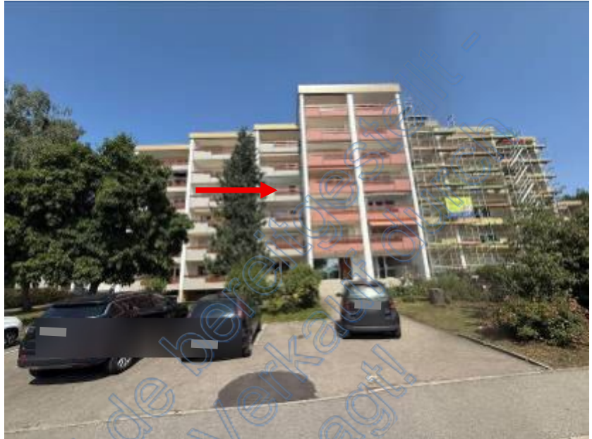
Foto 1 des SV: Silcherstraße 9 (Haus A); Ansicht von Süden (von der Silcherstraße); Detail: Lage der Wohnung Nr. 22; Pkw-Stellplätze
