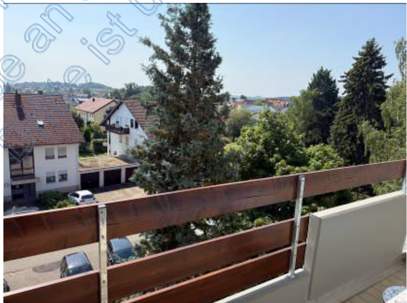
Foto 8 des SV: Wohnung Nr. 22; Loggia
