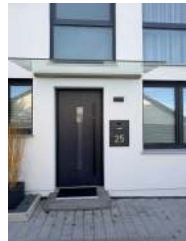
(12) Detail Hauseingang mit Glasvordach
