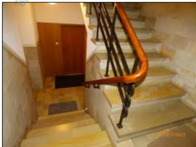
Ansicht: Treppenhaus Eingang Einheit EG (Bild 6)
