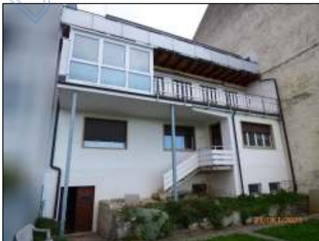
Ansicht: Südseite, Balkone, Wintergarten, Ausgänge (Bild 3)
