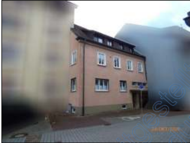
Ansicht: Nordansicht - Straßenfrontseite (Bild 1)
