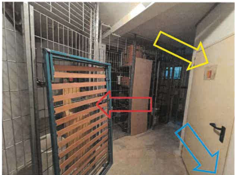
Vorraum der Keller- abstellräume (roter Pfeil zum Abstell- raum der Wohnung Nr. 2, gelber Pfeil zum Heizungsraum, blauer Pfeil zum Bereich ehemaliger Schäden nach einer Leckage)
