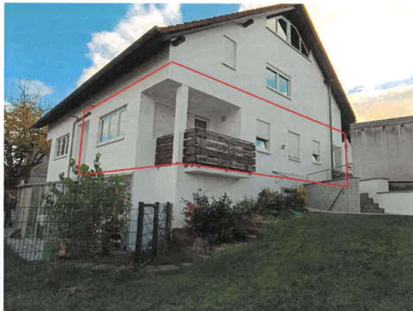
Ansicht von Norden (Lage der Wohnung 2 rot markiert)
