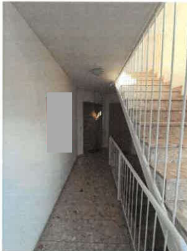
Linkes Bild: Treppenhaus im Bereich Erdgeschoss; rechtes Bild: Geschosstreppe zum Dachgeschoss
