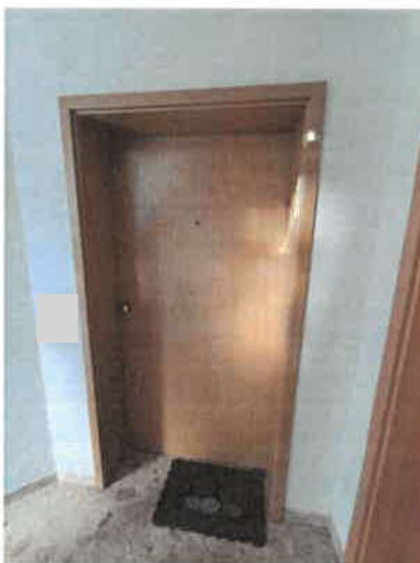
Linkes Bild: Wohnungseingangs- tür zu Wohnung Nr. 2 im Erdgeschoss; rechtes Bild: Geschosstreppe zum Untergeschoss, roter Pfeil zur Haustür an der Sandäckerstraße
