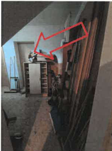
Linkes Bild: Kellervorraum im Untergeschoss; roter Pfeil zum Eingang des der Wohnung Nr. 2 zugeordneten Hobbyraums im Untergeschoss; rechtes Bild: Zähler- und Sicherungskasten im Untergeschoss
