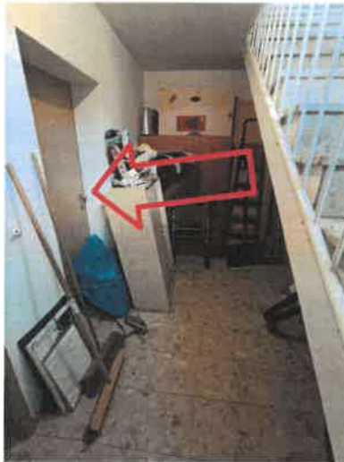
Linkes Bild: Treppenhaus mit Kellervorraum; roter Pfeil zum Eingang des der Wohnung Nr. 2 zugeordneten Hobbyraums im Untergeschoss; rechtes Bild: Wasch- und Trockenraum im Untergeschoss
