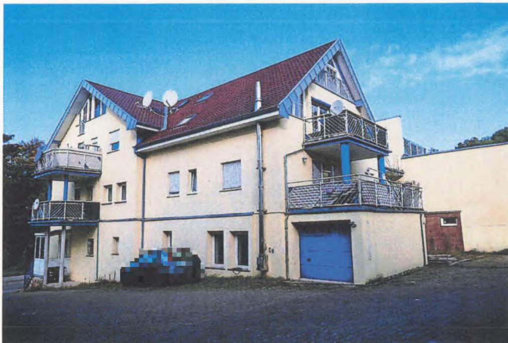
Blick vom Innenhof aus Richtung Südosten.
