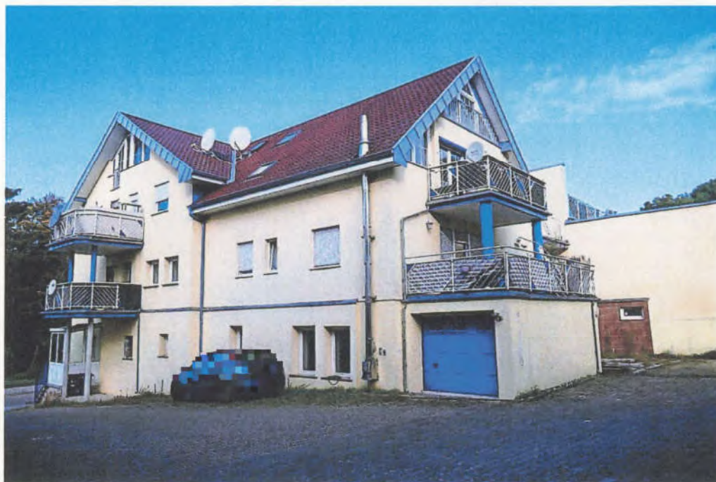
Blick vom Innenhof aus Richtung Südosten.
