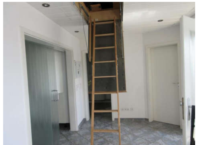
Einschubtreppe zum Spitzboden
