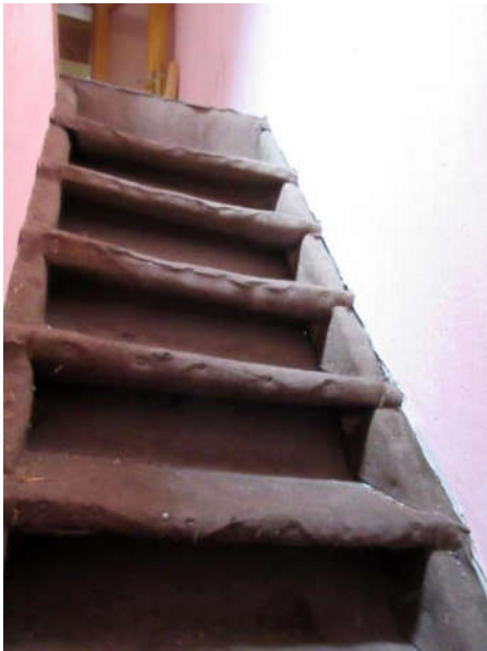
Treppe zum Dachgeschoss altes Wohnhaus
