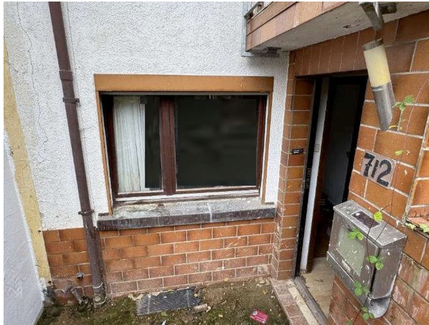
Bild 5: Zugang zur Einliegerwohnung im Erdgeschoss
