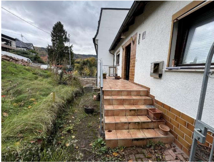
Bild 11: Treppenzugang zum Obergeschoss
