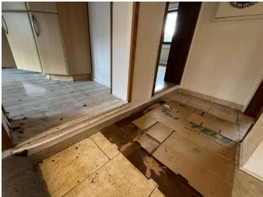
Bild 12: Flurbereich im Obergeschoss
