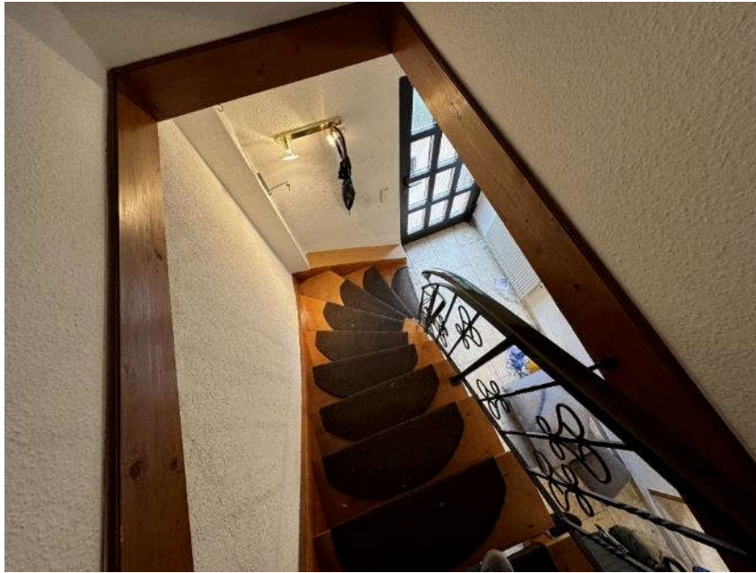
Bild 17: Geschosstreppe vom Obergeschoss zum Dachgeschoss
