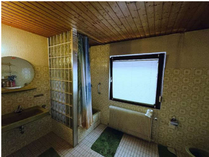
Bild 16: Badezimmer im Obergeschoss mit Fenster nach Osten
