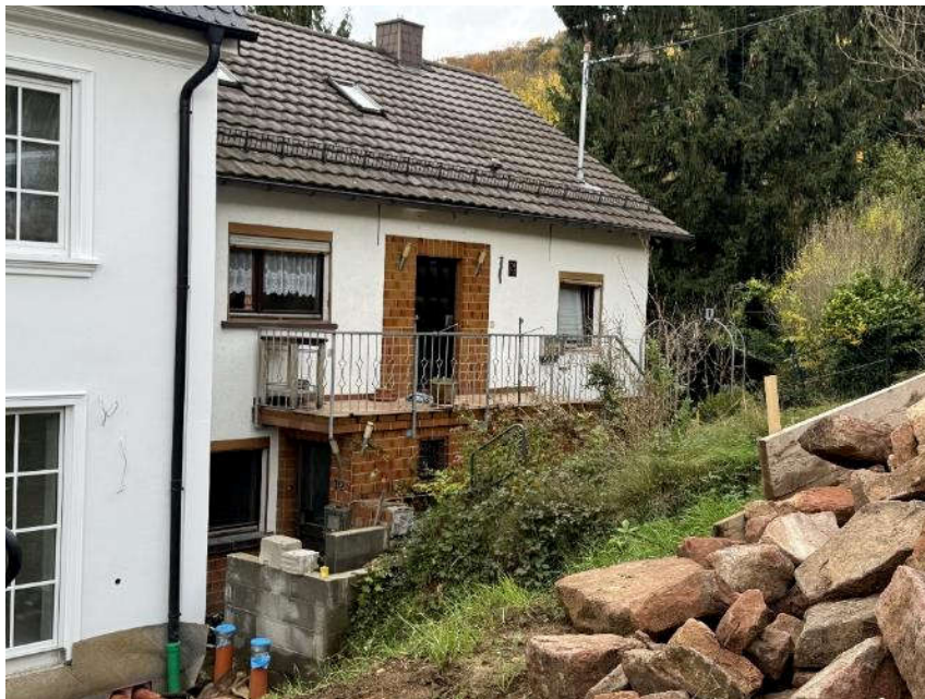
Bild 2: Gebäudeansicht von Südosten
