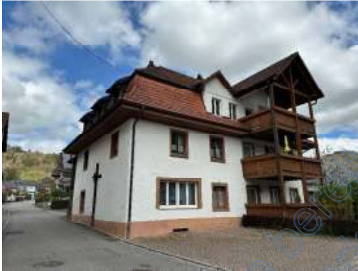
1 Blick auf das Grundstück mit der etwaigen Lage der Abgrenzung
