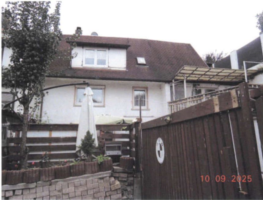
Bild 1: Ansicht aus nordöstlicher Richtung
