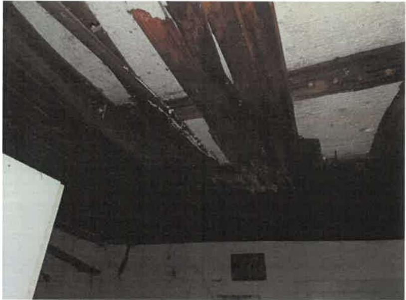
Linkes Bild: Teilweise eingebrochene Deckenkonstruktion im Erdgeschoss;
