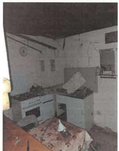
Teilweise eingebrochene Deckenkonstruktion im Erdgeschoss
