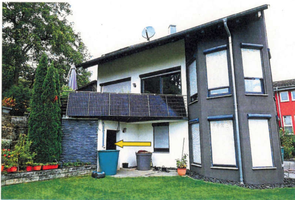
Blick auf die südliche Gebäudeseite. Der gelbe Pfeil zeigt auf den Zugang zum Abstellraum unter dem Balkon.
