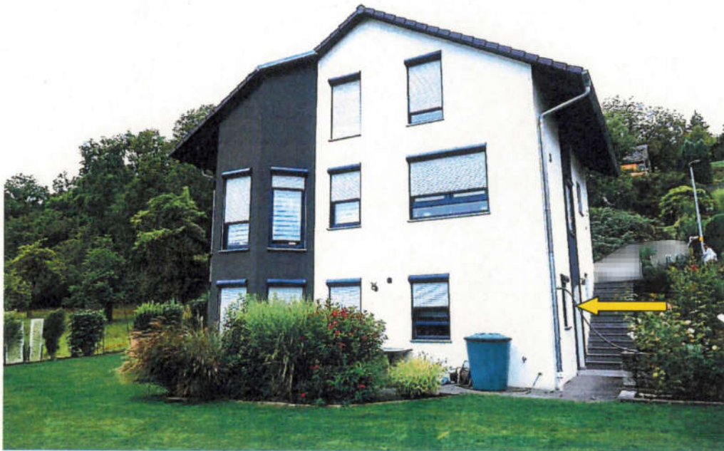
Ansicht des zu bewertenden Objekts von Osten. Der gelbe Pfeil zeigt auf den Zugang zur Einliegerwohnung im Untergeschoss.
