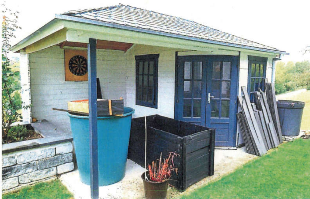
Ansicht des Pavillons. Dieser dient zur Lagerung von Gartenmöbeln.
