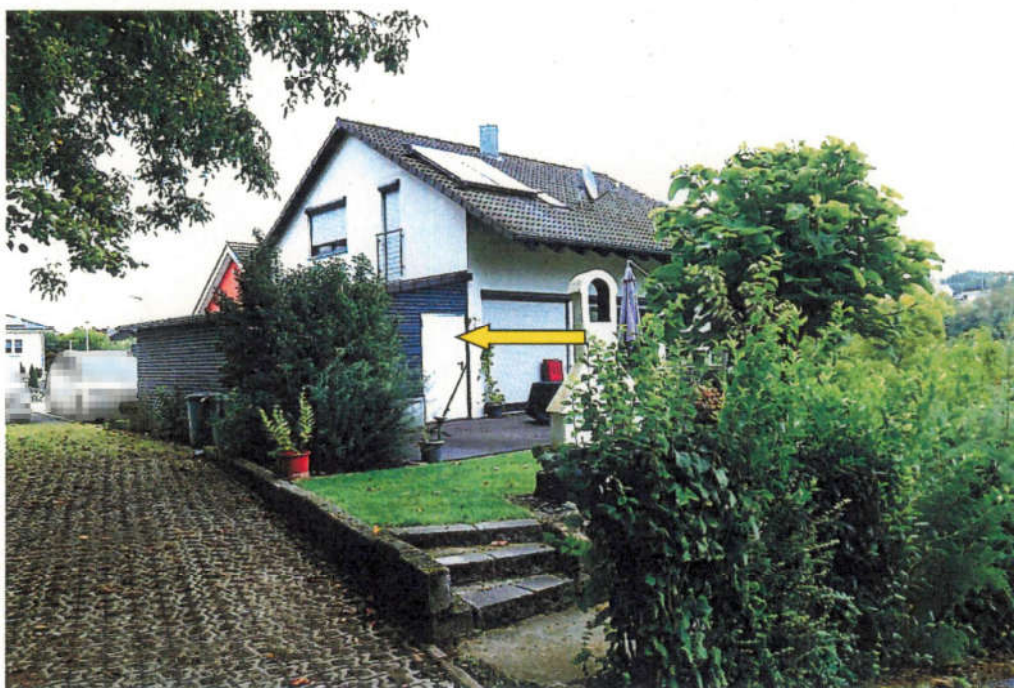
Ansicht des Wohnhauses mit Carport von Südwesten. Der gelbe Pfeil zeigt auf den rückwärtigen Zugang zum Carport.
