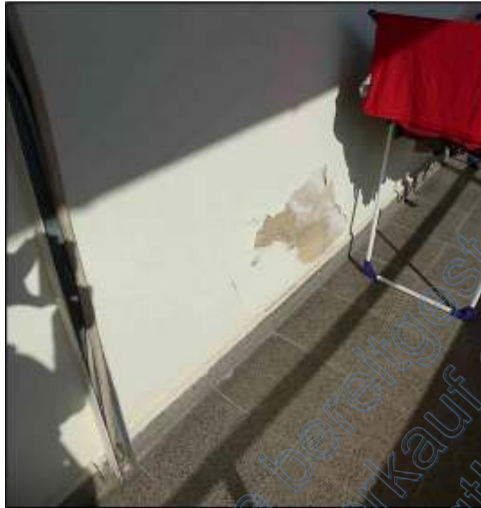
Bild 9 – Wasserschaden unter dem Badfenster
