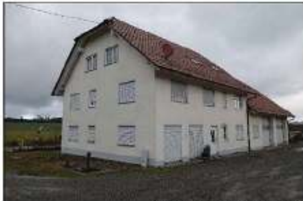
ZFH / Ansicht von Süden
