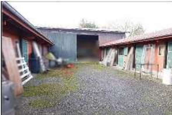
Innenhof nach Südwesten
