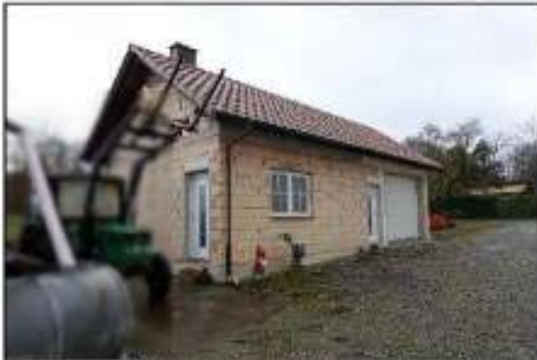
Nebengebäude / Ansicht von Norden
