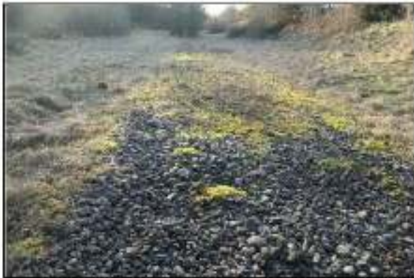
Gleiskörper der ehem. Bahntrasse nach SW
