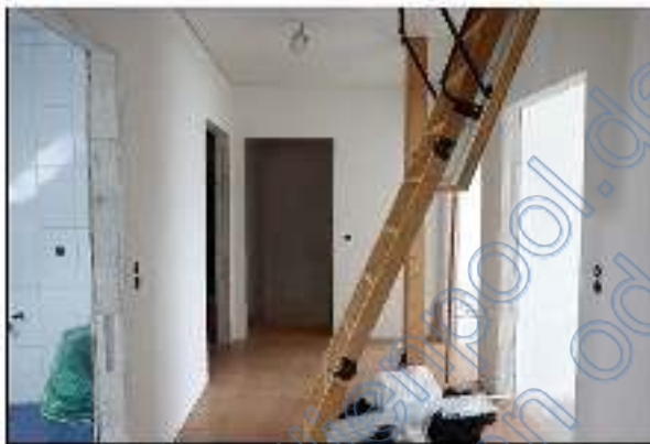
ZFH / Flur DG mit Einschuhleiter Dachstuhl
