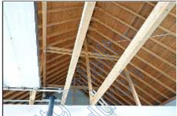
ZFH / Garagenanbau, Luftraum DG
