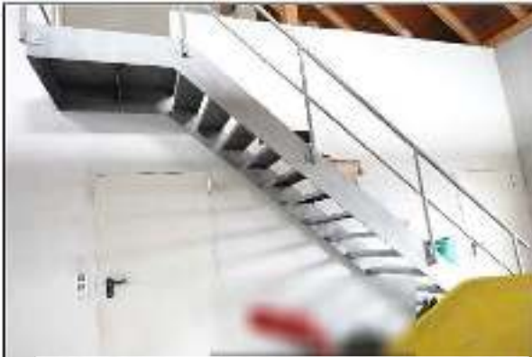
ZFH / Garagenanbau, Treppenaufgang Bühne
