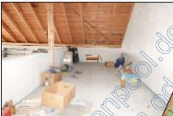
ZFH / Garagenanbau, Bühne
