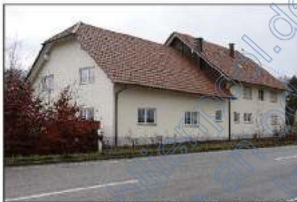
ZFH / Ansicht von Norden (L 194)
