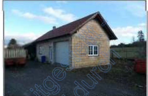
Nebengebäude / Ansicht von Westen
