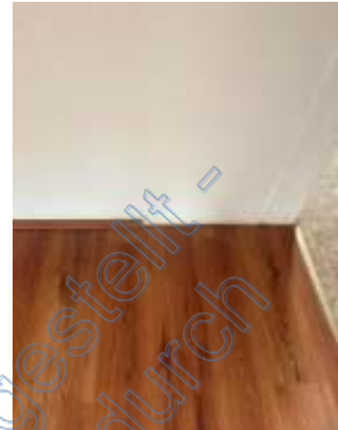
(77) Laminat z.T. fehlen Sockelleisten
