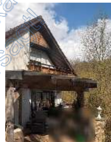
(71) Holzwerk am Giebel, Pergola und Balkon müssen gestrichen werden
