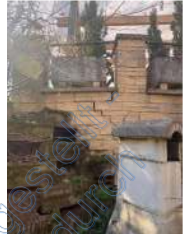
(68) Stützmauer der Terrasse ist gerissen
