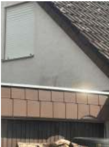
(66) Eternitschindeln sind asbesthaltig und mit Abplatzungen
