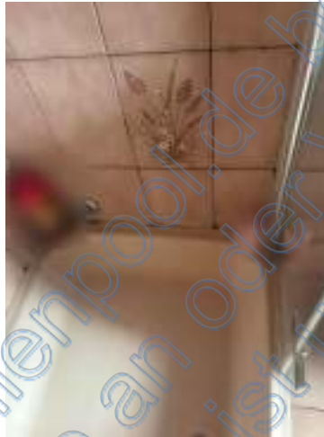
(79) Schimmel im Duschbereich Fuge ist undicht
