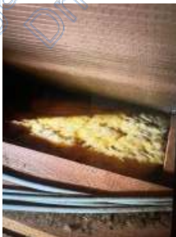
(82) Dämmung mit Glaswolle
