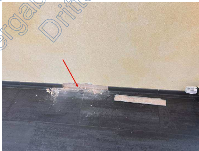
Foto 21: EG (Gewerbebeeinheit): Sockelleiste schadhaft
