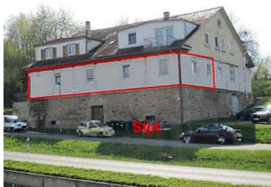
Nordostansicht Wohnung 1 rot umrandet
