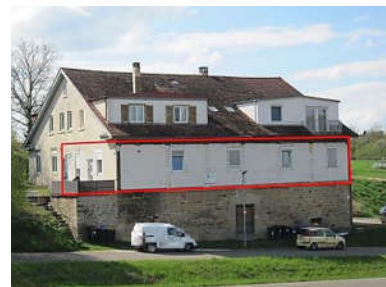
Südostansicht Wohnung 1 rot umrandet
