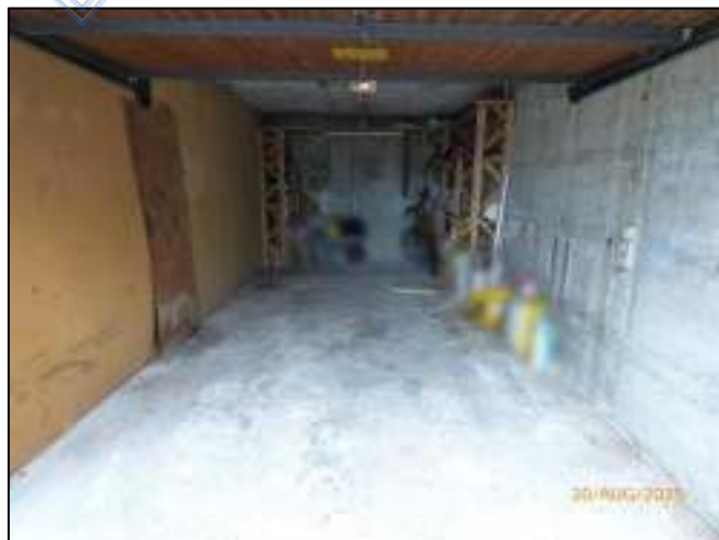
Ansicht: Garage (Bild 24)
