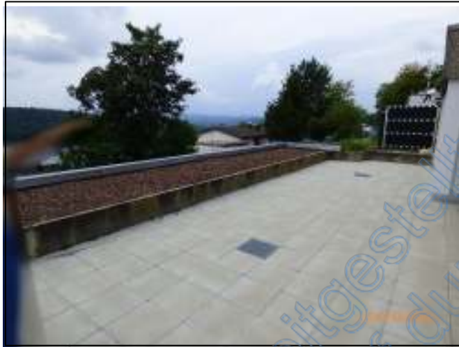
Ansicht: Dachterrasse (Bild10)
