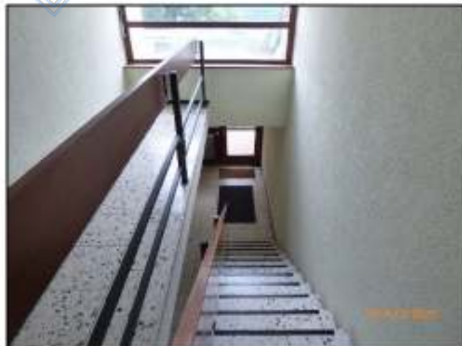
Ansicht: Treppenhaus (Bild 6)
