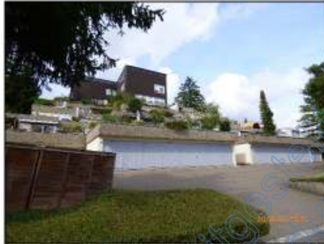
Ansicht: Südseite (Bild 1)
