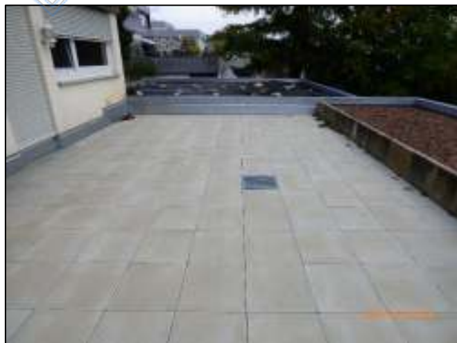
Ansicht: Dachterrasse (Bild 12)
