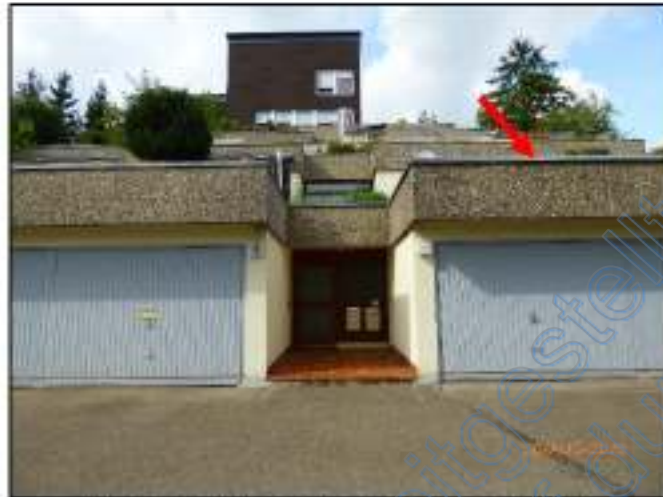
Ansicht: Südseite Hauseingang (Bild 4)
