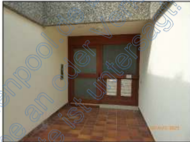
Ansicht: Hauseingang (Bild 5)
