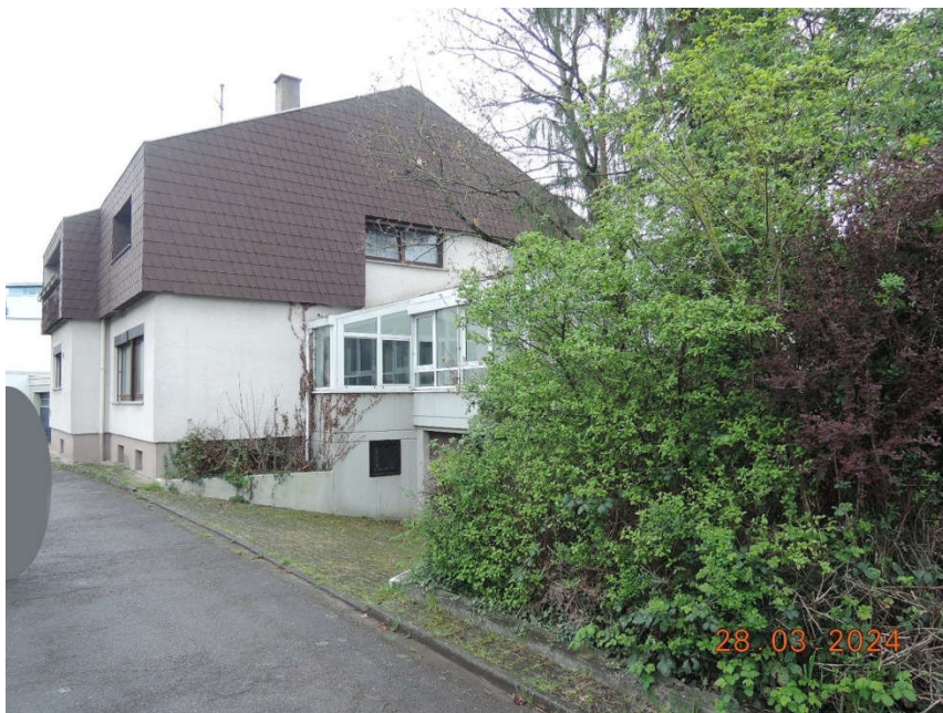
Bild 26: Giebelansicht aus nordöstlicher Richtung
