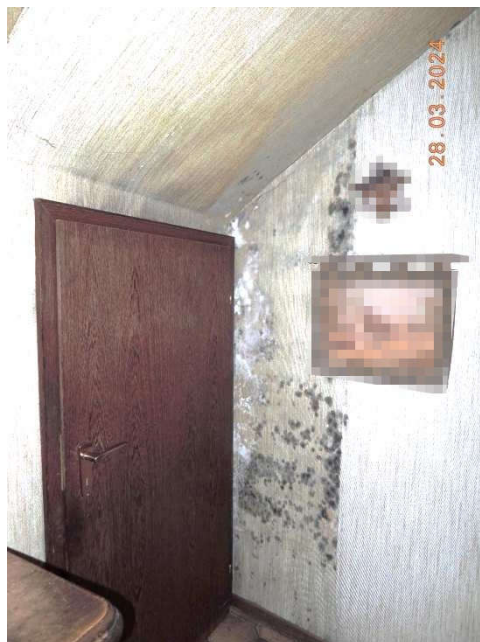
Bild 16: Tür zur Kellertreppe in der Diele
