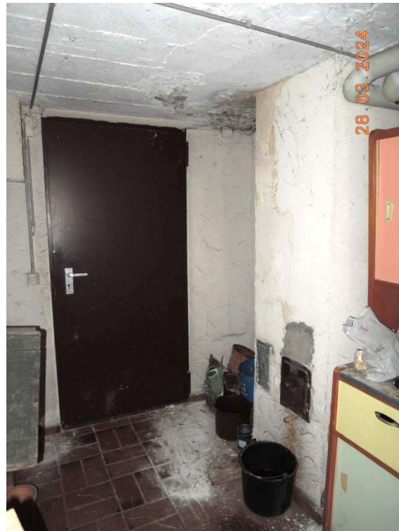
Bild 21: Kellergeschoss, Feuchtigkeitsschaden
