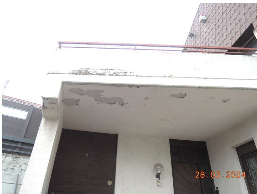
Bild 14: Ansicht der Dachterrasse (Hauseingangsüberdachung) von unten
