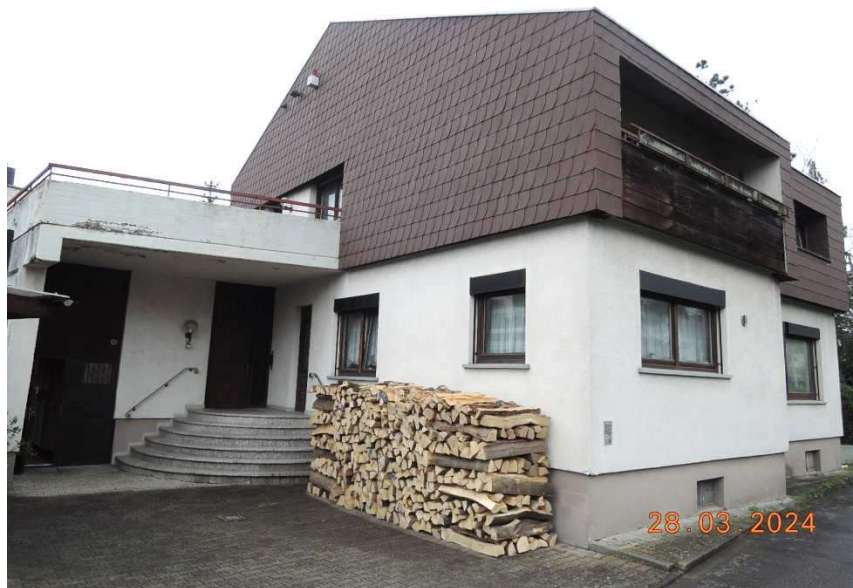
Bild 1: Straßenansicht aus südlicher Richtung
