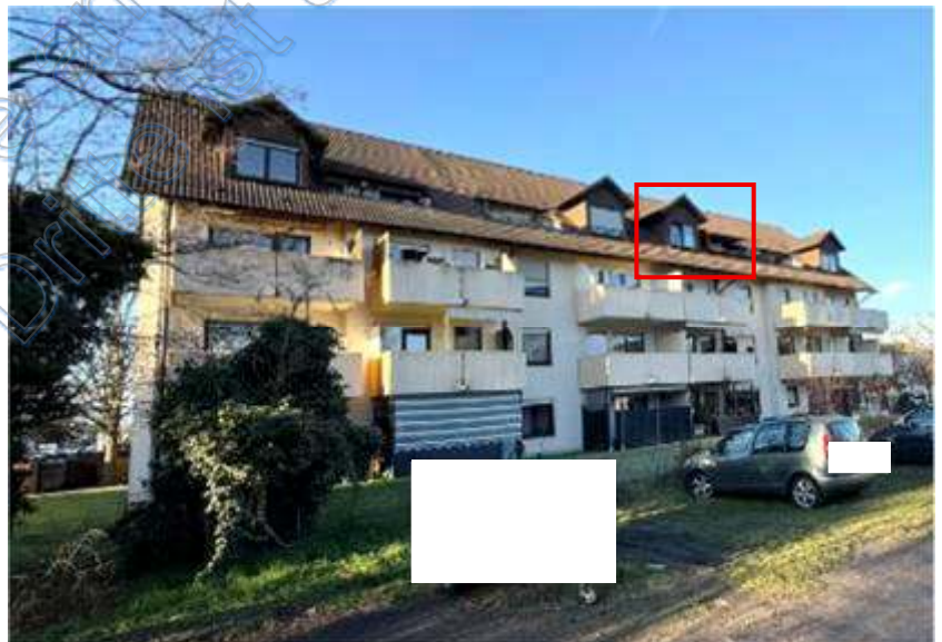
Foto 2 des SV: Stolzeneckstraße 6, 6a, Gebäuderückseite; Ansicht von Südosten; Detail: Wohnung Nr. 64; Rotmarkierung d.d. SV
