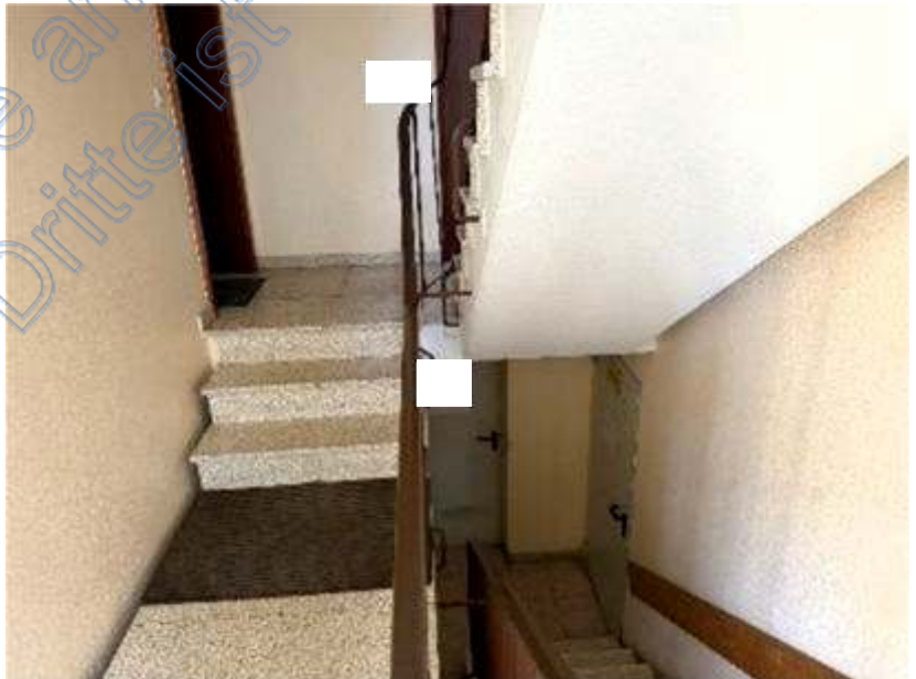
Foto 6 des SV: Stolzeneckstraße 6a, Treppenhaus EG
