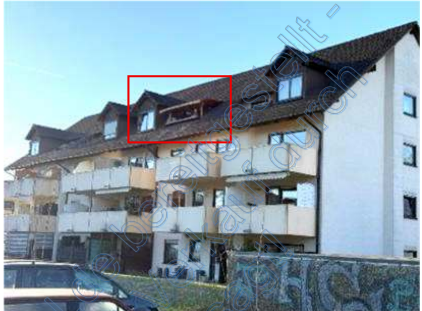
Foto 3 des SV: Stolzeneckstraße 6, 6a, Ansicht von Nordosten; Gebäude- rückseite; Detail: Wohnung Nr. 64; Roteintragung d.d. SV
