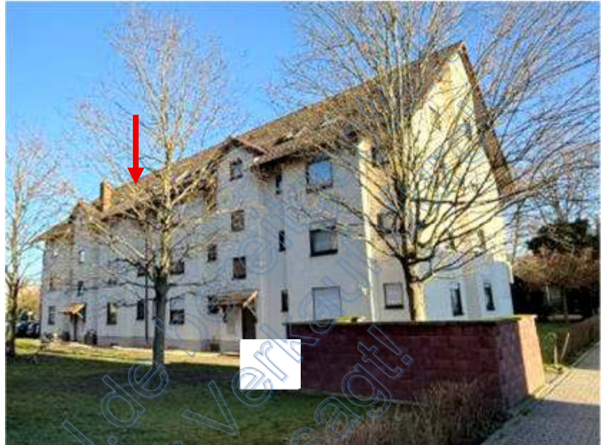
Foto 1 des SV: Stolzeneckstraße 6, 6a, Gebäudeeingangsseite; Ansicht von Westen, Straßenansicht: Detail (Pfeil): grob schematische Lage der Wohnung Nr. 64; Rotmarkierung d.d. SV
