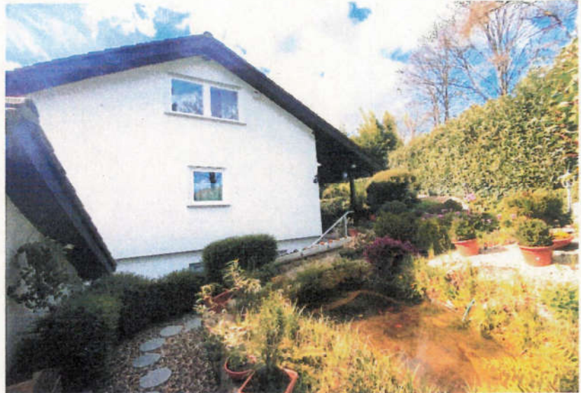
Foto 3 des SV: Ansicht von Osten
