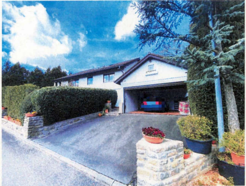
Foto 1 des SV: Ansicht von Südosten; Wohngebäude und Garagenzufahrt, Ansicht von der (Stich-)Straße Im Schlot; Anonymisierung d.d. SV
