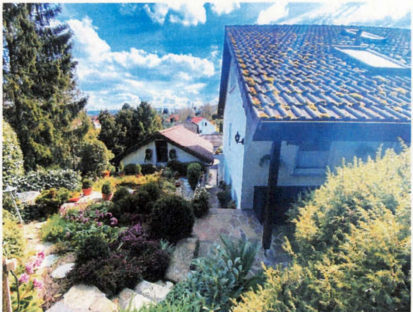
Foto 2 des SV: Ansicht von Norden, vom Garten
