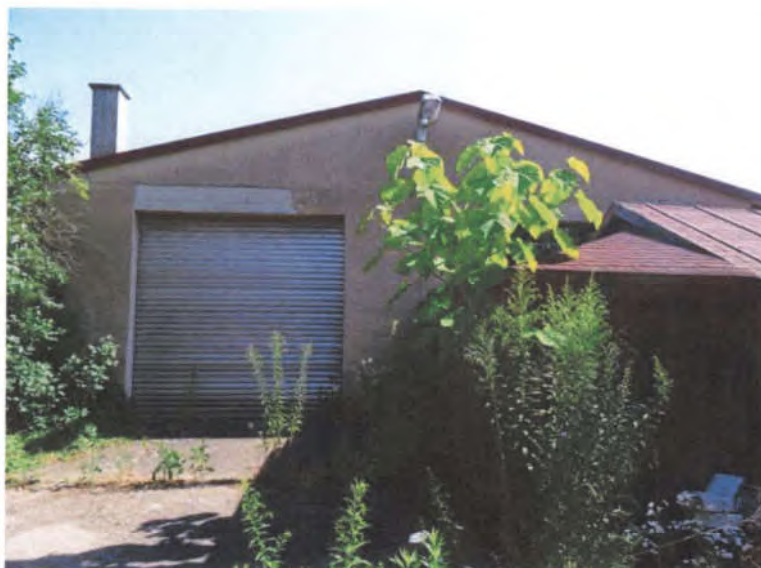
Foto 5: Ansicht Gebäude 2, Südwestseite
