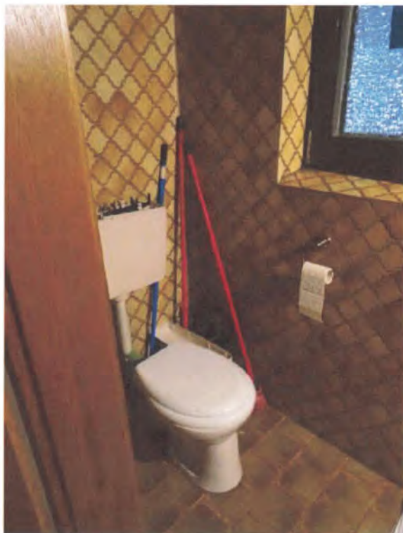
Foto 18: WC im OG
