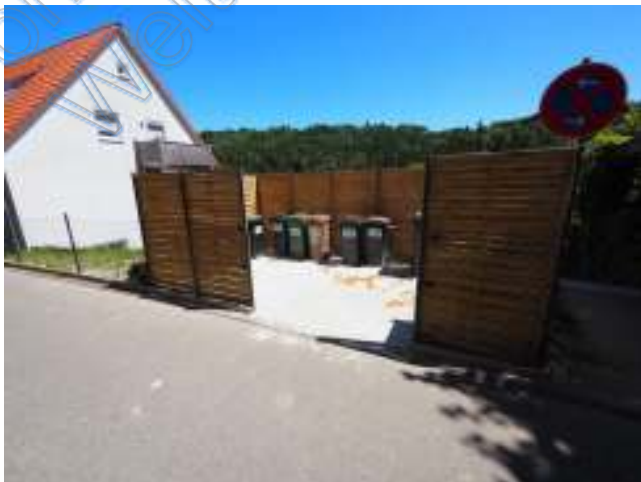
Mülltonnen Lageplatz auf der Nordostseite des Grundstücks
