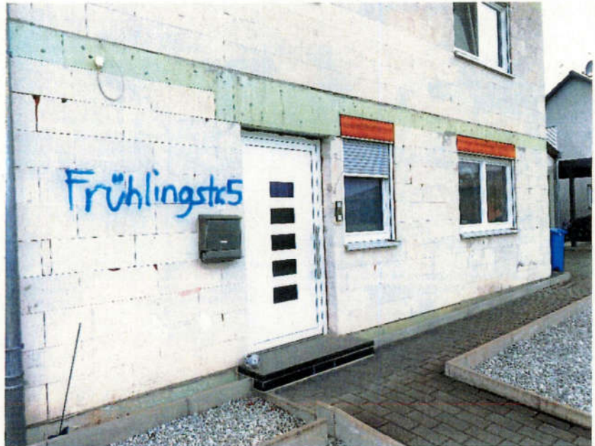
Foto 5 des SV: Untergeschoss, Gebäudeeingang
