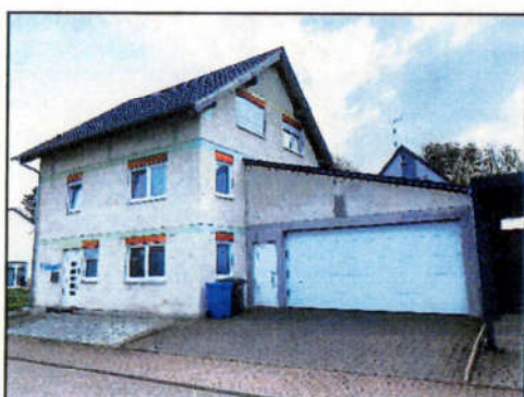
Einfamilienhaus mit (Doppel-)Garage
