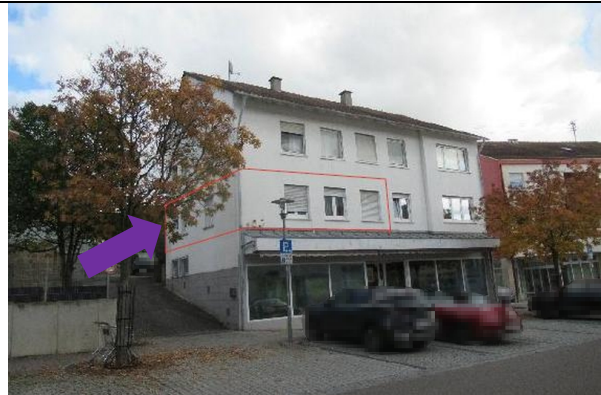
Ansicht von der Bachstraße/ Südwesten
