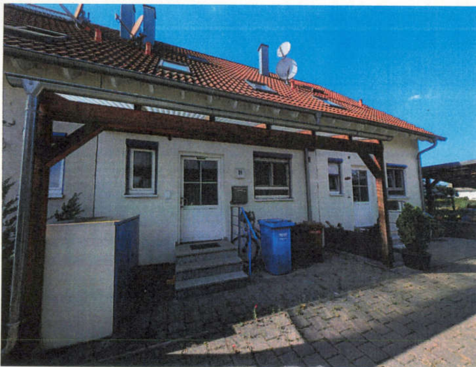
Ansicht von Westen nach Osten
