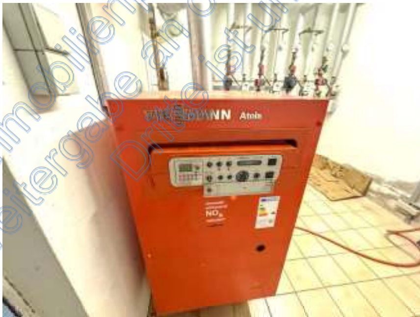
Bild 48: Gas-Zentralheizung
