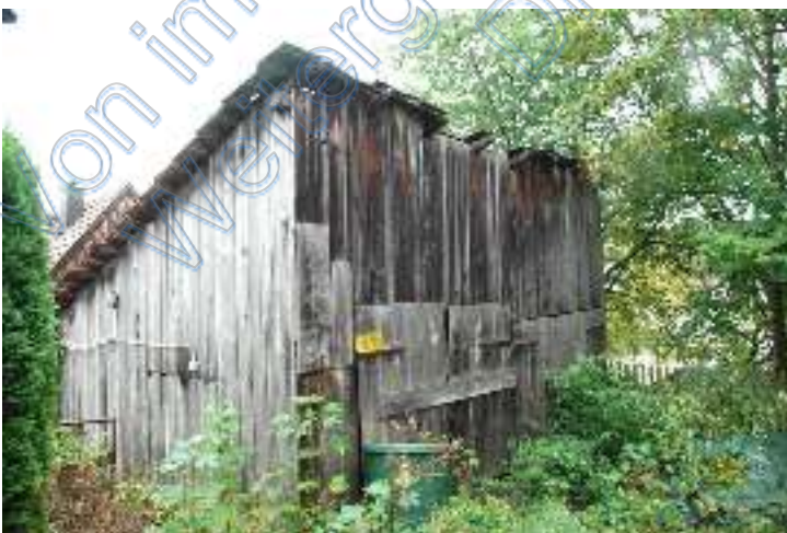
(10) Ansicht Nebengebäude vom Mühlweg
