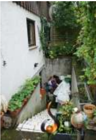
(28) Außentreppe auf der Südseite
