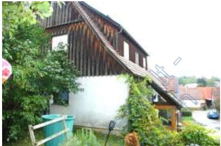
(29) Putzfassade im Sockelbereich auf der Südseite
