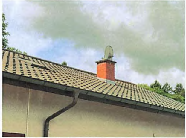
Beispiel Dacheineckung, -rinnen und -aufbauten (hier: nördliche Dachfläche)
