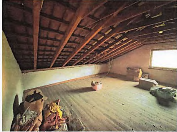
Speicher im Dachgeschoss (westlicher Gebäudeteil), zur südwestlichen Gebäudeecke hin
