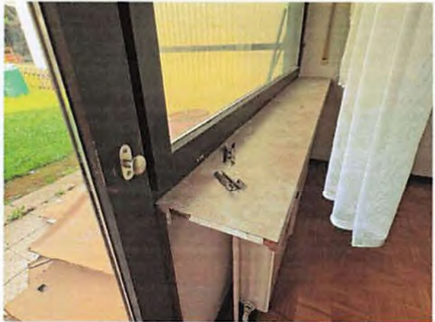
Beispiel für Fenster (hier: Essplatz im Erdgeschoss)
