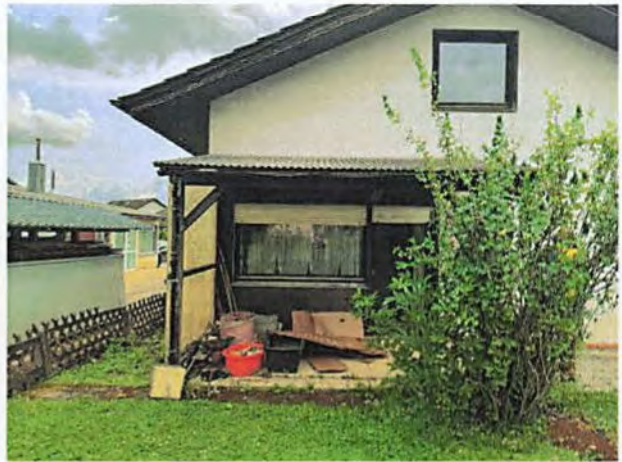
Ansicht westliche Giebelseite, links der benachbarte Gewerbebetrieb (Fenster im Dachgeschoss gehört zum Speicher)
