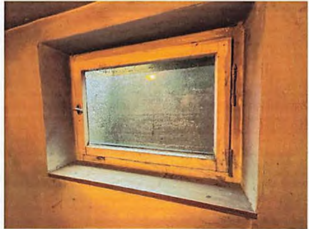
Beispiel Fenster im Untergeschoss (hier Heizungsraum)
