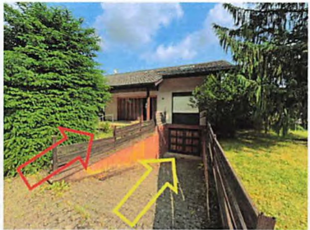
Hauszugang (roter Pfeil) und Zufahrt zu der in das Untergeschoss integrierten Garage (gelber Pfeil), jeweils auf südlicher Traufseite an der Straße „Im Rauchleder“
