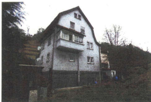
Ansicht aus Süden (Rückseite)
