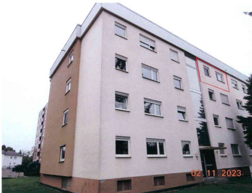
Bild 1: Ansicht aus nordöstlicher Richtung
