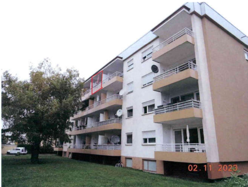
Bild 6: Ansicht aus südöstlicher Richtung
