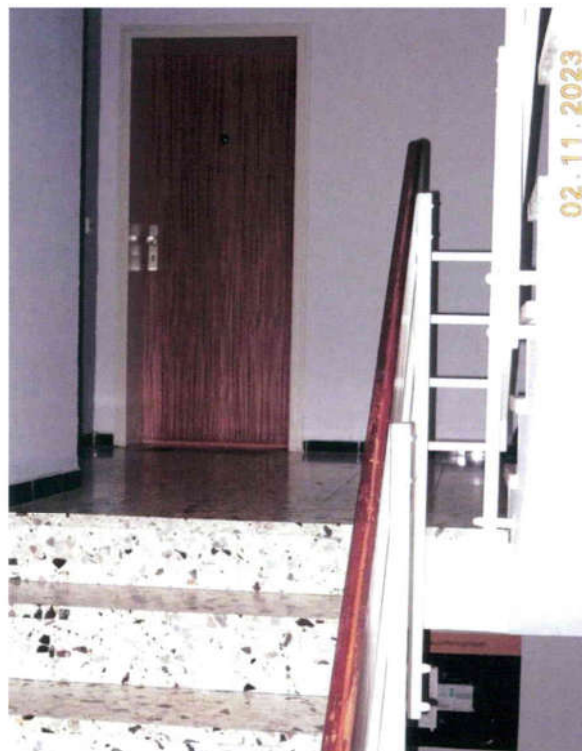
Bild 4: Treppenhaus und Wohnungseingang
