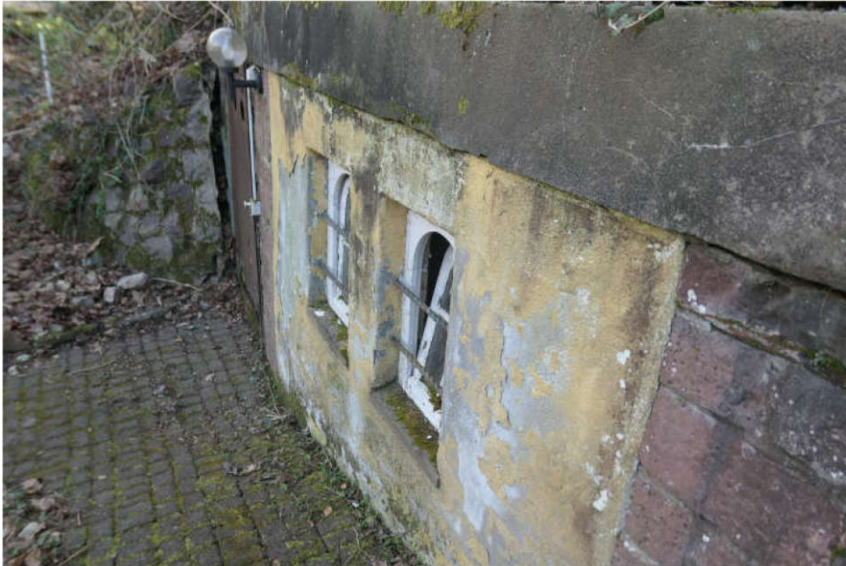
Eingang Fluchttür aus dem Keller ins Freie
