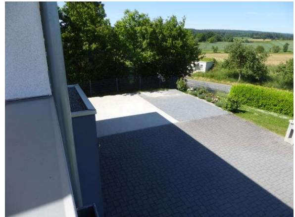
15. Blick nach Norden
