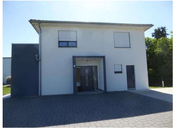
2. Blick von Nordosten
