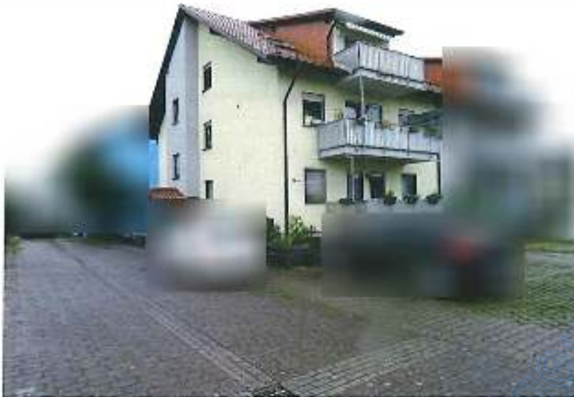
Foto 3: Ansicht von der Straße aus
