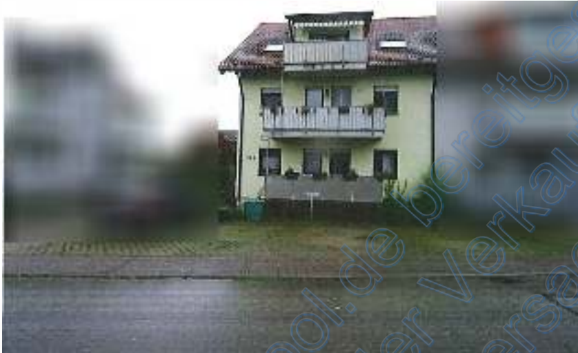
Foto 1: Ansicht von der Straße aus
