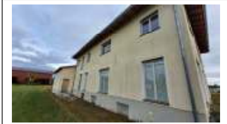
b) Rep.-Stau (Anstrich) Fassade
