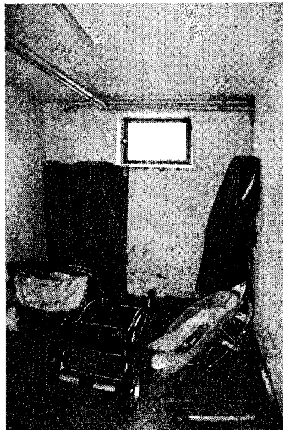
Bild 14: Untergeschoss, 2. Kellerraum, für Wohnung Bewertungsobjekt SE 2
