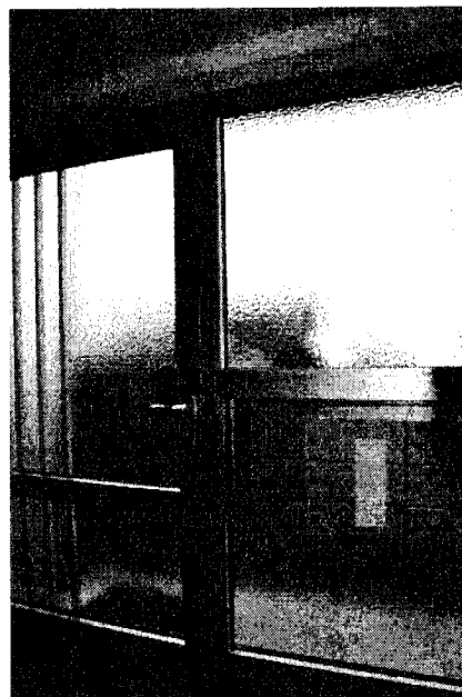
Bild 10: Erdgeschoss Haustür, Eingang Vorderes Hägle 1
