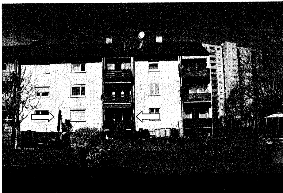
Bild 4: Ostansicht, Bewertungsobjekt Erdgeschoss, linker Balkon (Pfeil)
