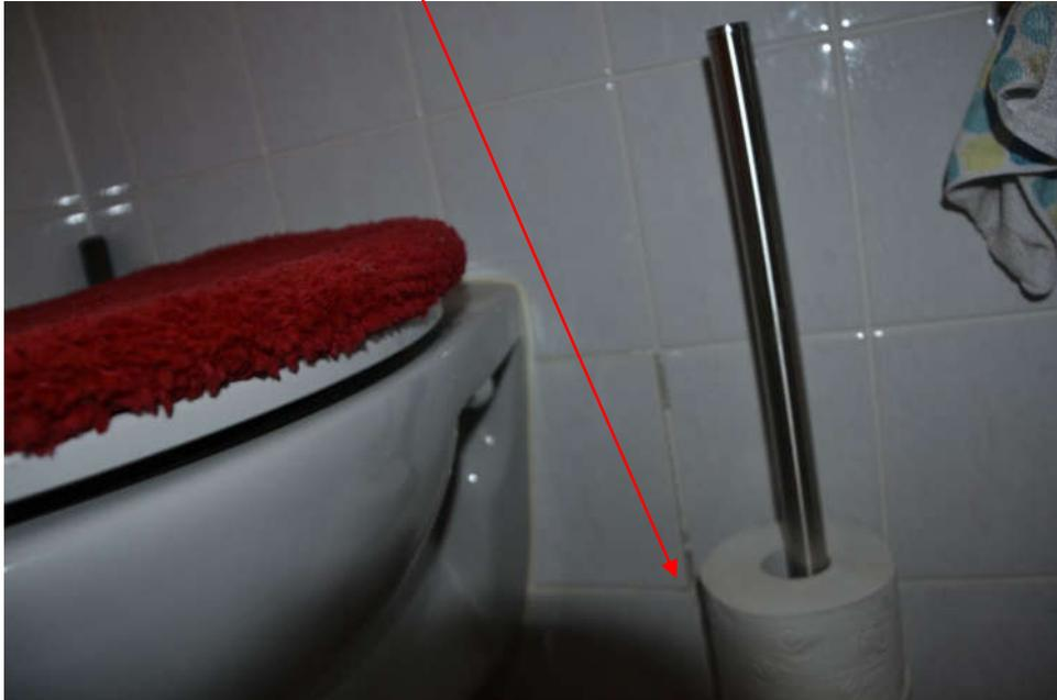
Bild 15: Erdgeschoss WC, defekte Fliesen (Pfeil)
