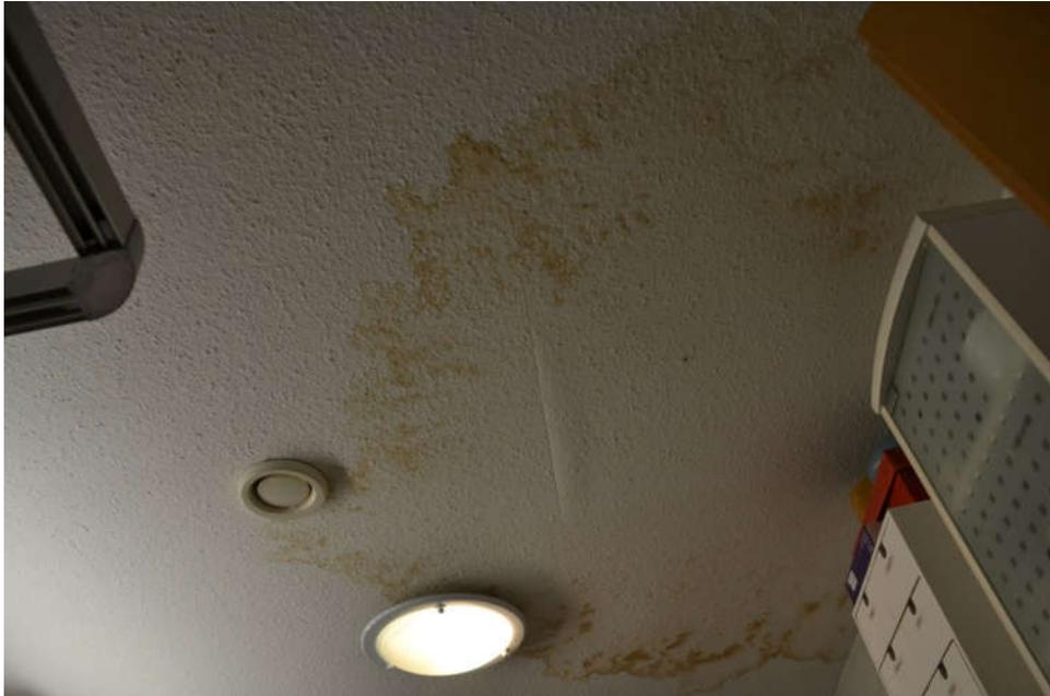
Bild 13: Erdgeschoss Bad, ehemaliger Wasserschaden an der Geschossdecke
