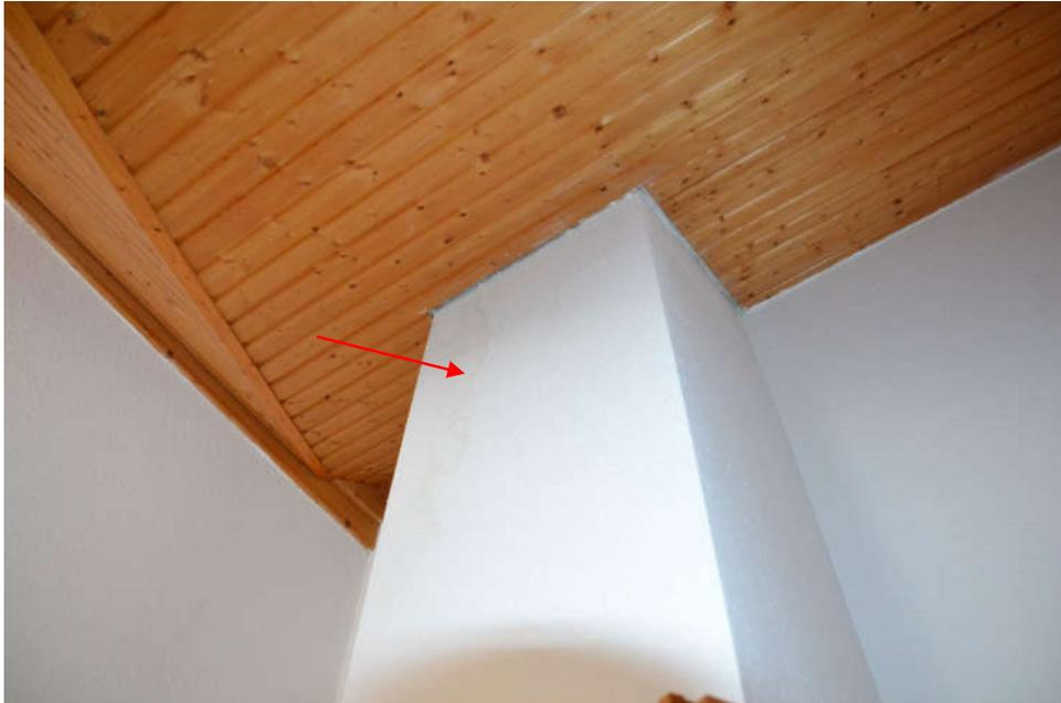
Bild 17: Dachgeschoss Zimmer, Feuchtigkeitsschaden (Pfeil)
