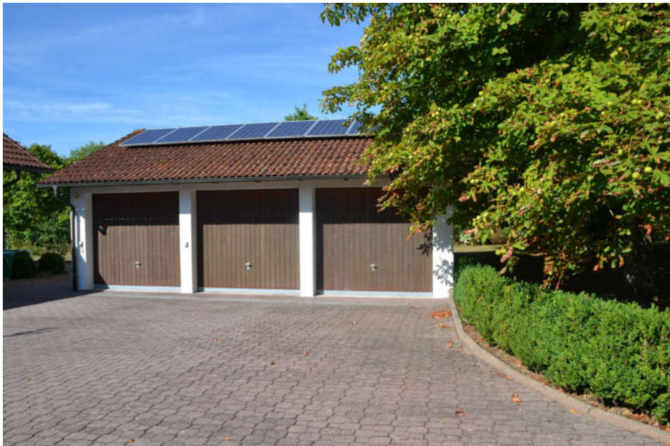
Bild 20: Ostansicht der Garagen
