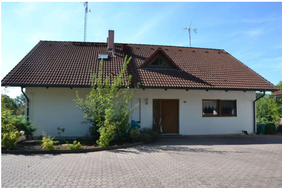
Bild 4: Nordansicht des Einfamilienhauses
