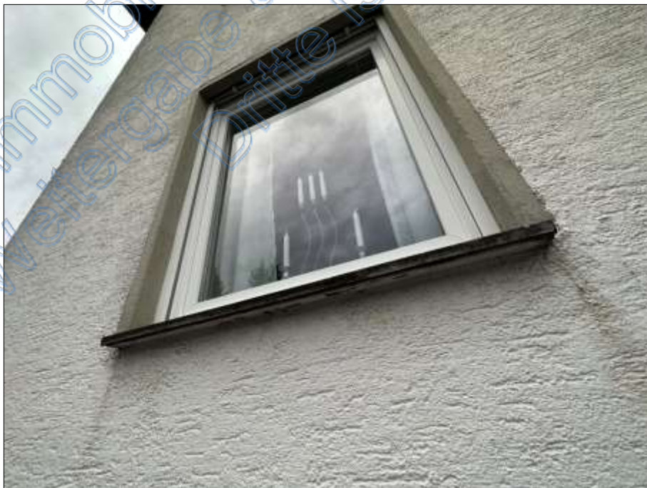
Bild 8: Detail – Kunststoffisolierfenster Fasanengarten 1
