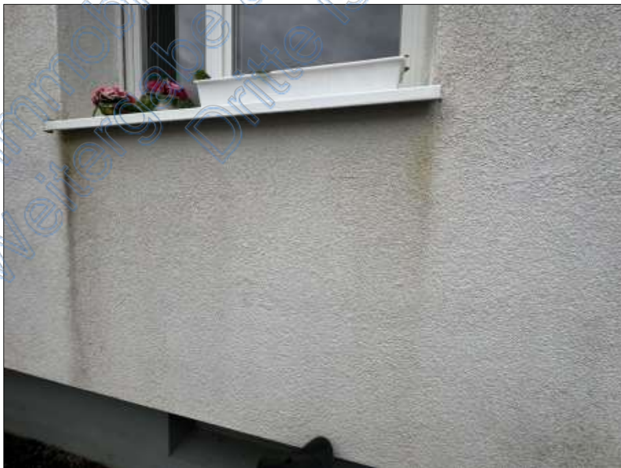
Bild 18: Detail – Verschmutzung Fassade
