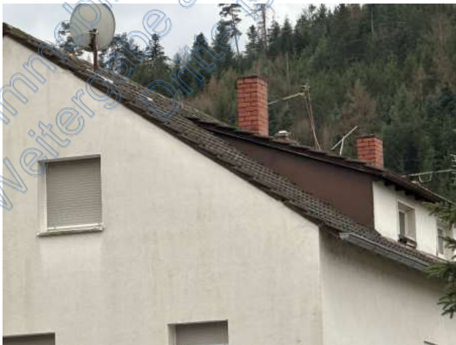
Bild 16: Detail – Bedachung mit Schleppdachgaube
