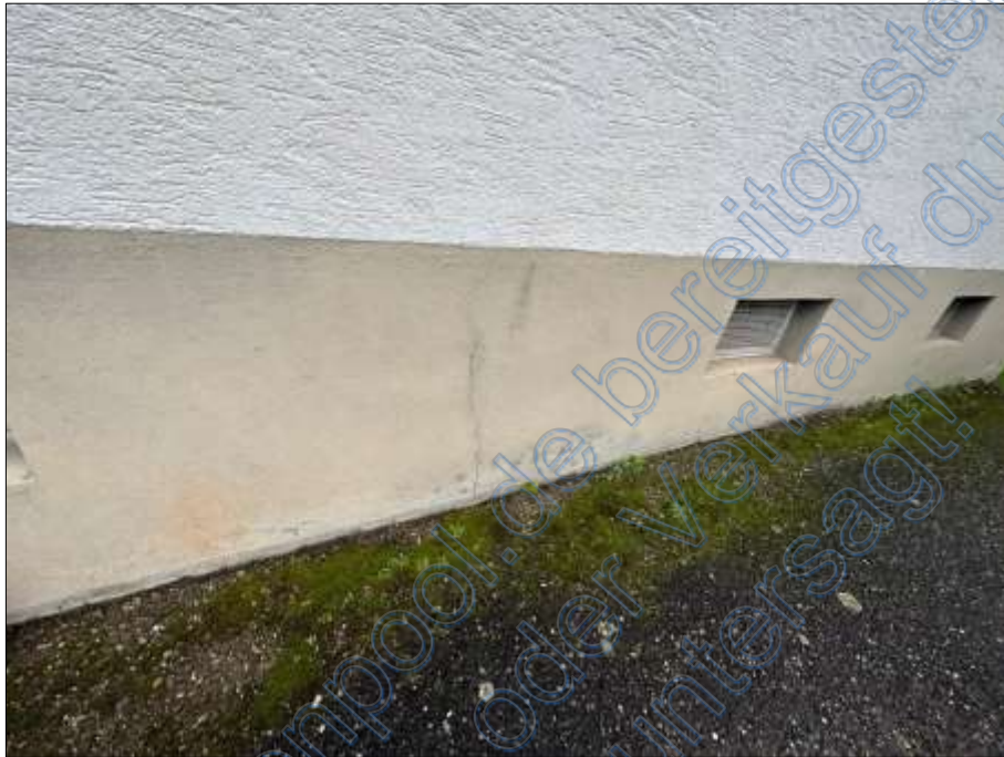
Bild 9: Fasanengarten 10, Putzrisse im Sockelbereich
