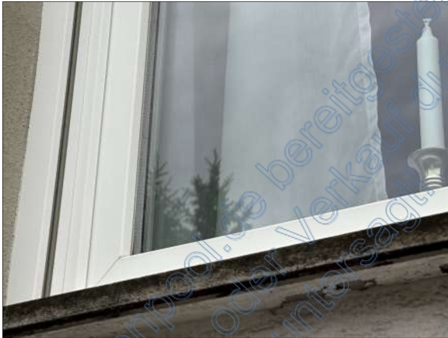
Bild 19: Detail – Kunststoffisolierfenster Fasanengarten 12
