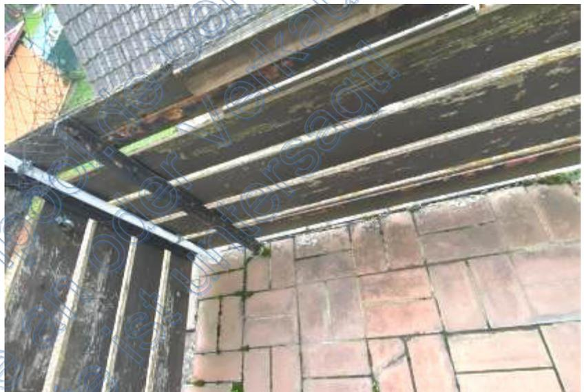
**Abb. 10:** Foto des SV; z.T. Bodenbelag u. Brüstung Balkon schadhaft (DG)
