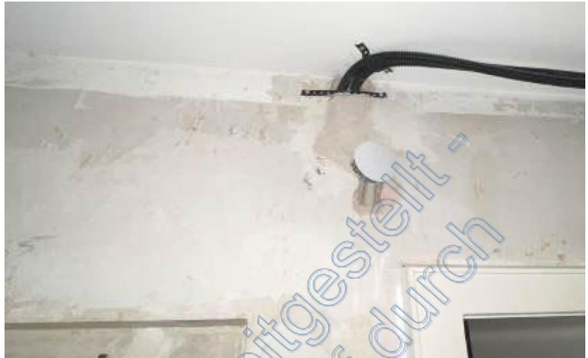
**Abb. 6:** Foto des SV; z.T. Wandbekleidungen fehlend, Elektroleitungen unfertig/auf Putz (EG)
