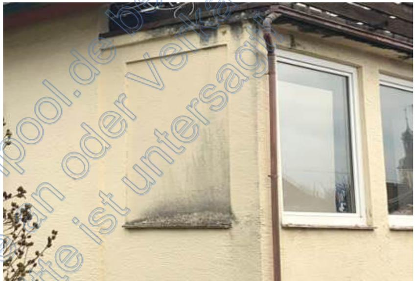
**Abb. 4:** Foto des SV; z.T. Fassade schadhaft (Putzverfärbungen)
