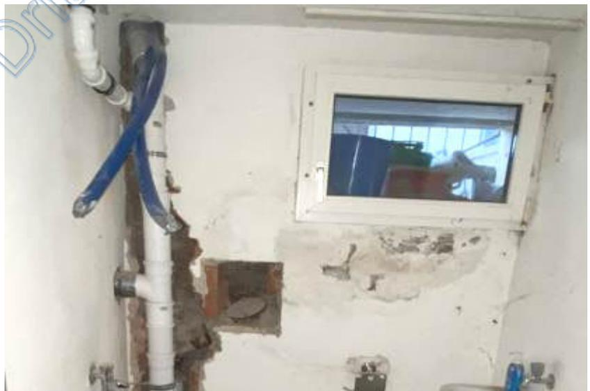
**Abb. 11:** Foto des SV; z.T. Feuchteschäden in Außenwandbereichen, unverschlossene Leitungsschlitz (KG)
