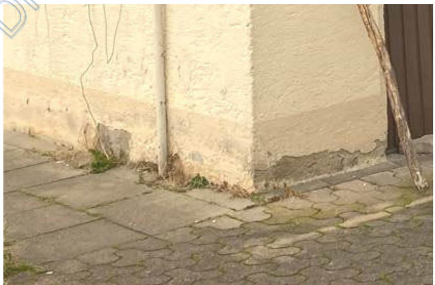
**Abb. 5:** Foto des SV; z.T. Fassade schadhaft (Putzabplatzungen)
