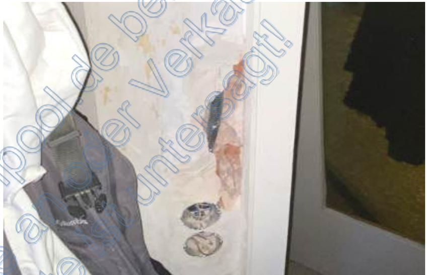
**Abb. 7:** Foto des SV; z.T. Leitungsschlitze unverputzt, Schalter- und Steckdosenabdeckungen fehlend, Wandbekleidungen fehlend (EG)
