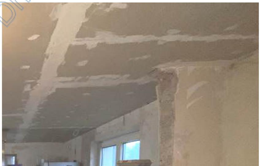
**Abb. 8:** Foto des SV; z.T. unfertige Wand-/Deckenbekleidungen z.T. unfertig gestellte Verputzarbeiten (EG)
