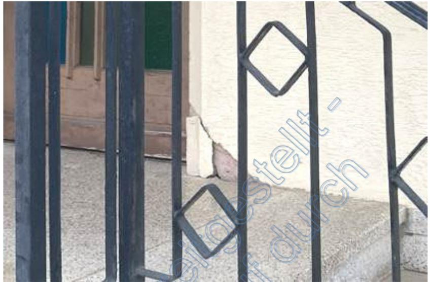
**Abb. 3:** Foto des SV; z.T. Fassade schadhaft (Putzabplatzungen)
