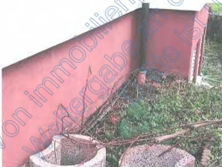
Bild 6 Feuchtigkeit im Sockelbereich (ELW)
