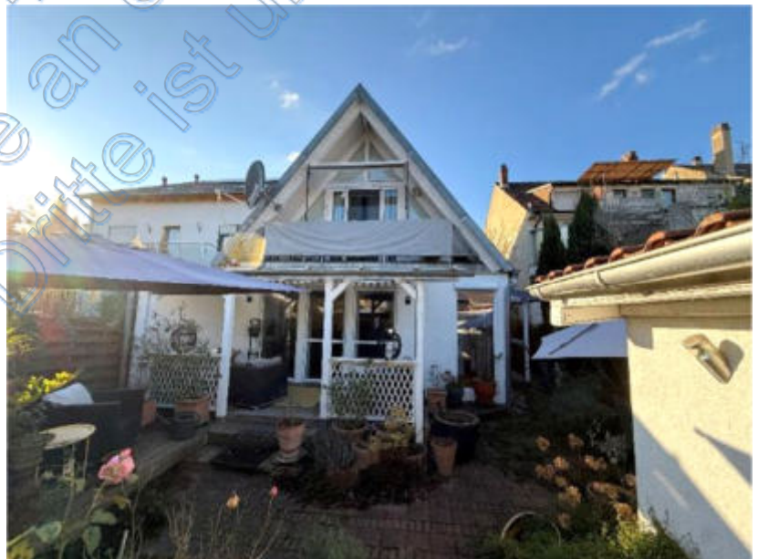
Foto 4 des SV: Ansicht von Osten, vom Garten; Gebäuderückseite
