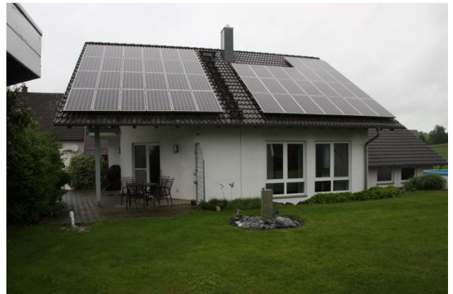
Ansicht von Süden, Terrasse und PV-Anlage
