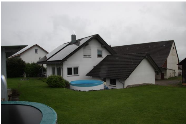
Ansicht von Osten
