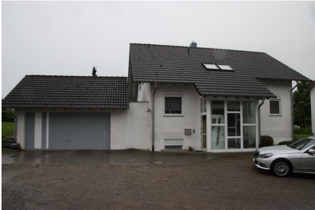
Ansicht Norden, Hauseingang und Doppelgarage
