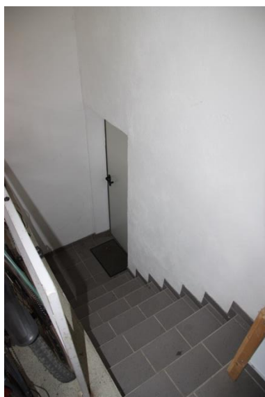
Treppenabgang von Garage zum KG
