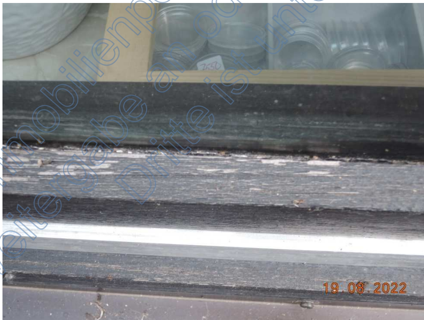
Bild 6: Detailaufnahme verwittertes Fenster aus Holz
