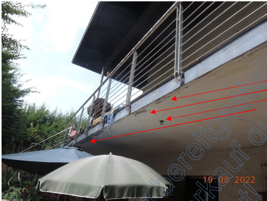
Bild 2: Balkon im EG (sichtbare Durchfeuchtungsschäden)
